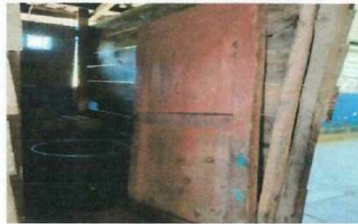
Foto 14: CAMBIO DE LA PUERTA DE MADERA A METAL, LA PUERTA DE LA COCINA
