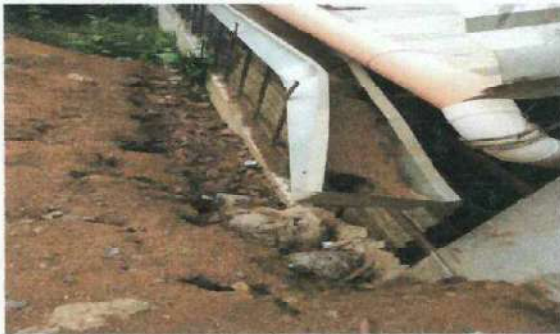
Foto 3: CAMBIO DE CANALES
