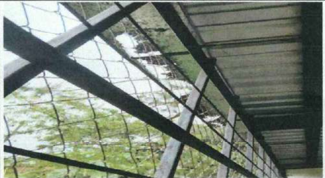
Foto 2: CAMBIO DE CANALES A LAMINAS EN TODO EL CORREDOR DE LA ESCUELA
