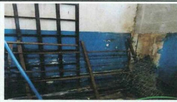
Foto 4: REPELO Y PINTAR EL AREA DONDE SE ENCUENTRA ACTUALMENTE UNA BODEGA Y EL PASILLO DE LA ENTRADA
