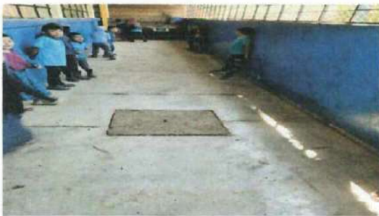
Foto 15: CAMBIO EL PISO DE CEMENTO A AZULEJOS CORREDOR
