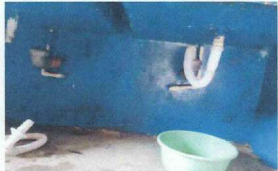
Foto 4: MEJORAMIENTO DE LAS TUBERIAS DE AGUA Y BAÑOS
