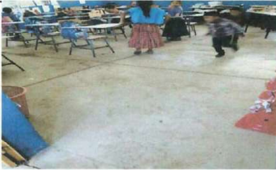
Foto 13: CAMBIO DE TORATA DE CEMENTO DE LAS AULAS 1,2, DIRECCION Y CORREDOS A CERAMICO,
