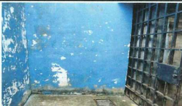
Foto 3: CAMBIO DE LA BARANDILLA A UN PORTON DE METAL
